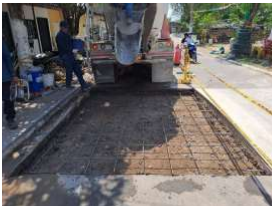
Obra de instalación de reductores de velocidad
