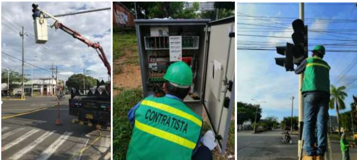
Jornadas de mantenimiento correctivo y preventivo de la Red de Semaforización
